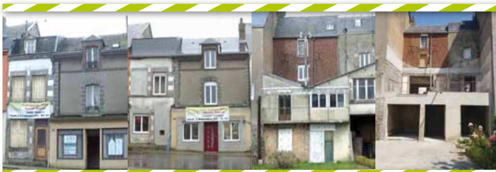
Vues avant et pendant les travaux
